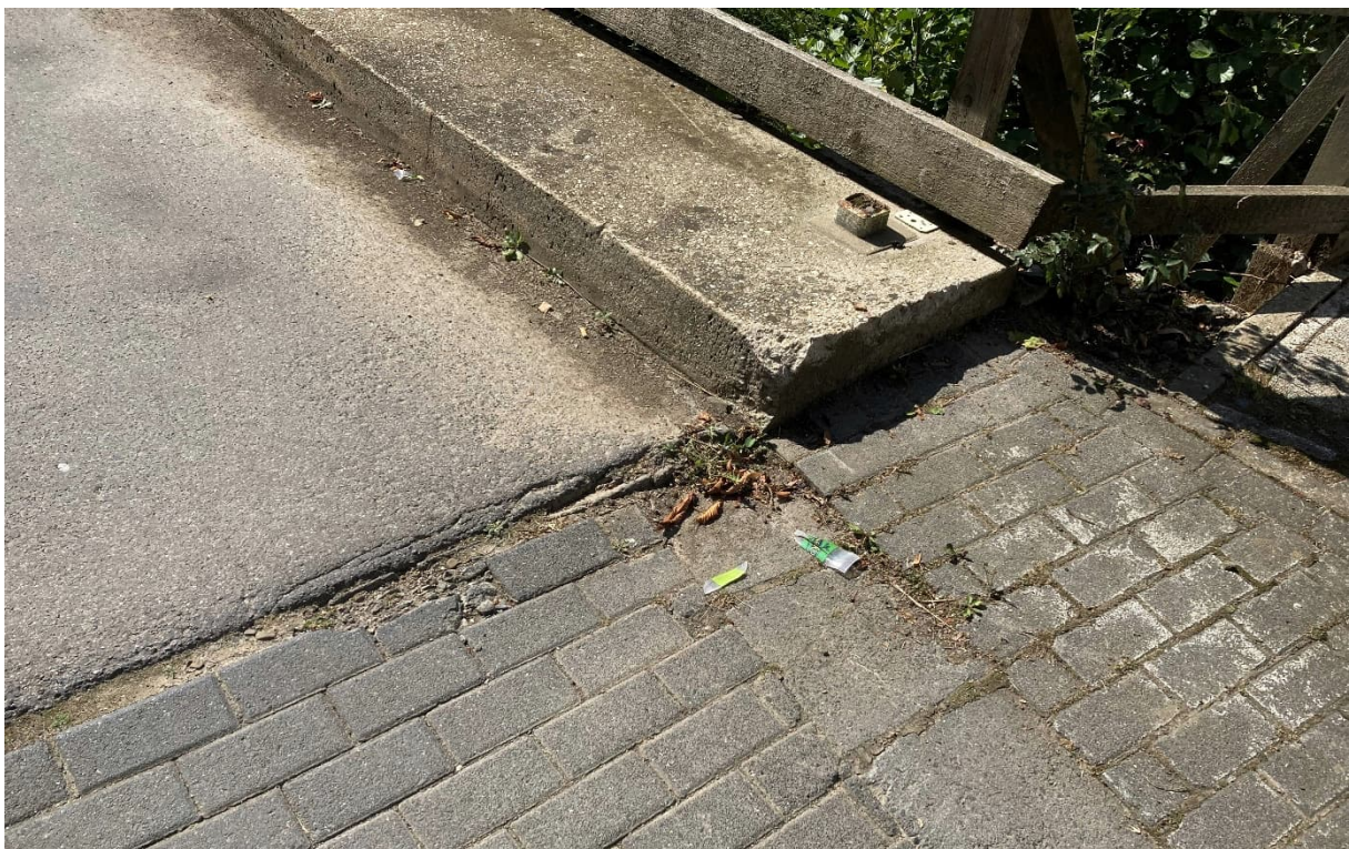
Bild 5 + Bild 6: Fahrbahnübergang und Brückenköpfe
