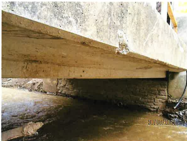
8-KANTENBRÜCHE STIRNSEITE ÜBERBAU
