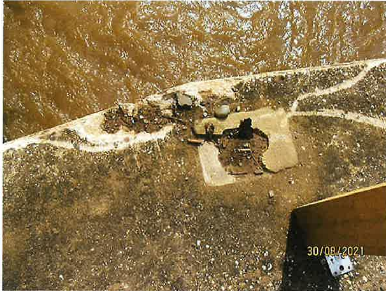
7-AUSBRÜCHE GESIMS BEREICH GELÄNDERPFOSTEN
