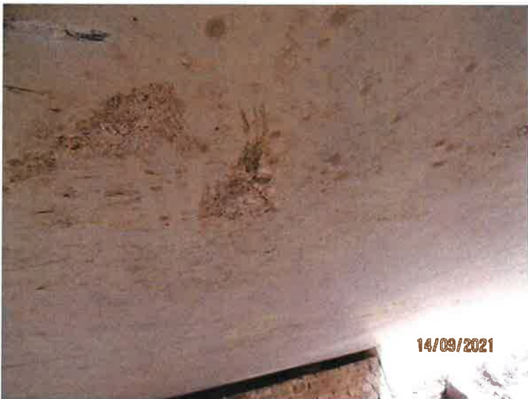
9-SCHRAMMSPUREN UNTERSEITE ÜBERBAU
