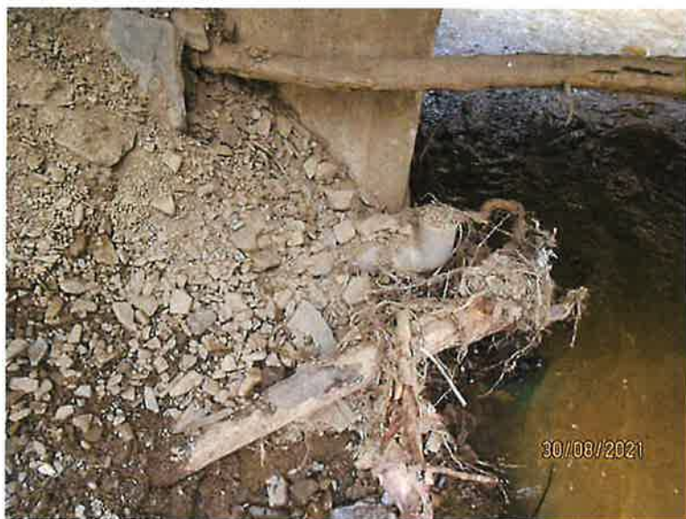
5-BÖSCHUNG FLÜGELBEREICHE ABGESACKT
