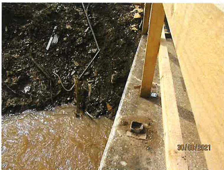
6-GELÄNDER FEHLT VOLLSTÄNDIG
