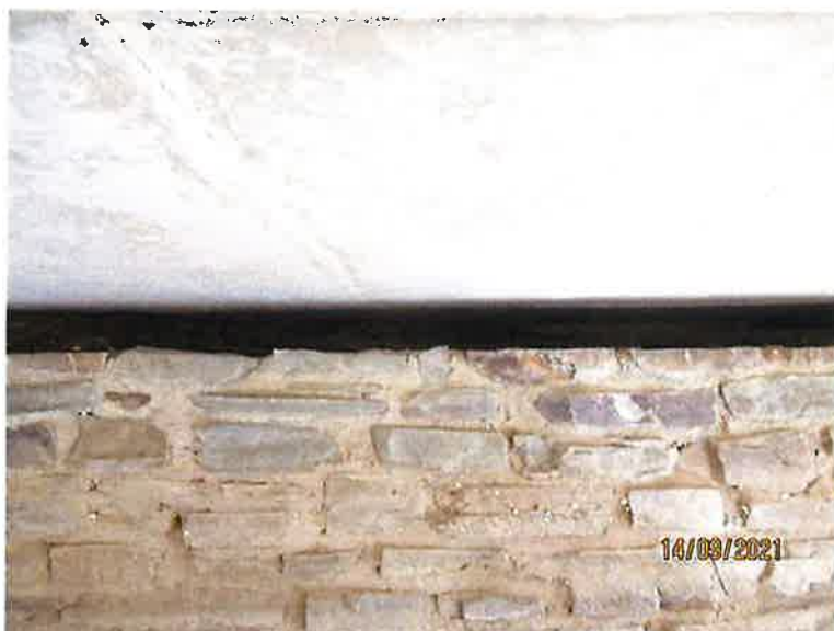
10-SCHMUTZABLAGERUNGEN AUFLAGERBEREICH
