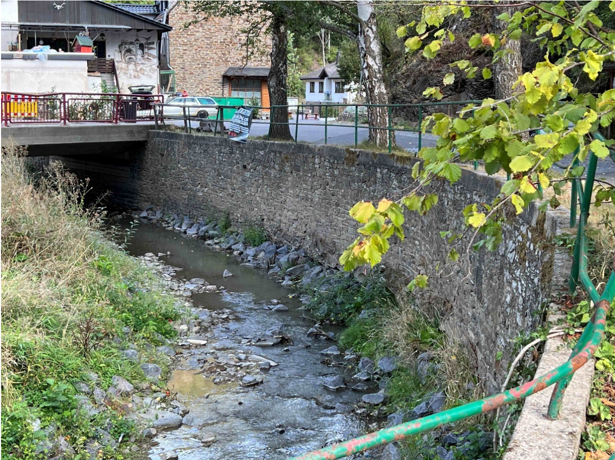
Bereich Lagerfläche, spätere Freianlage Gewerk 3:
