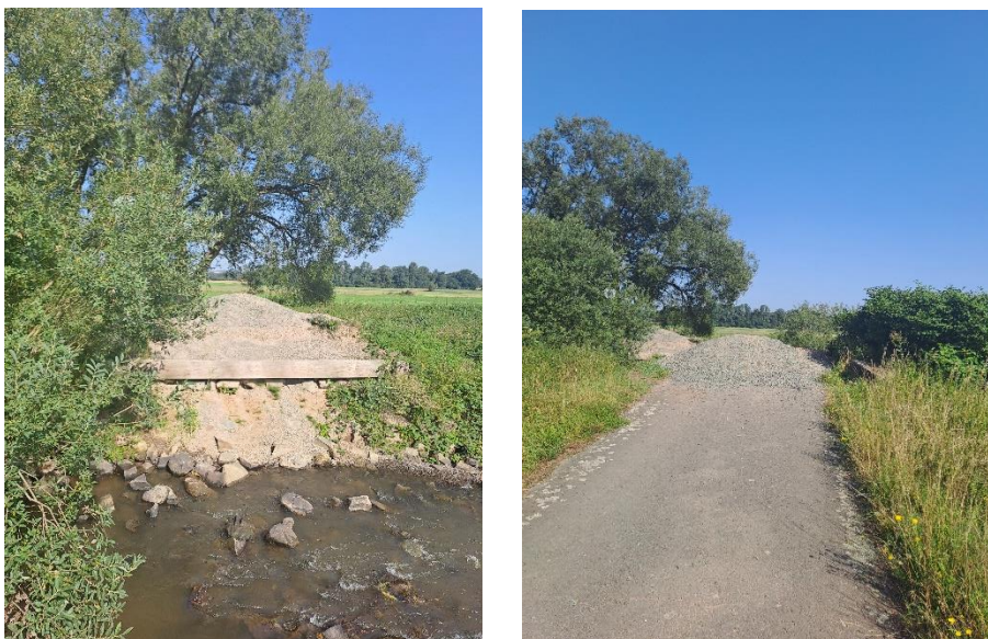
Abbildung 3: Bestehendes Bückenfundament und Zufahrtsstraße (2025)
