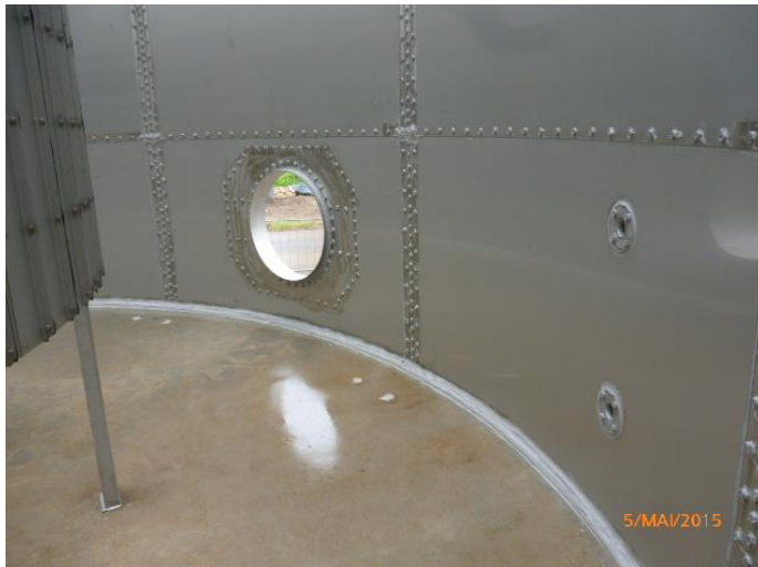
Bild: Faulbehälter KA Edenkoben, Segmentbauweise
