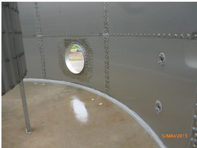
Bild: Faulbehälter KA Edenkoben, Segmentbauweise
